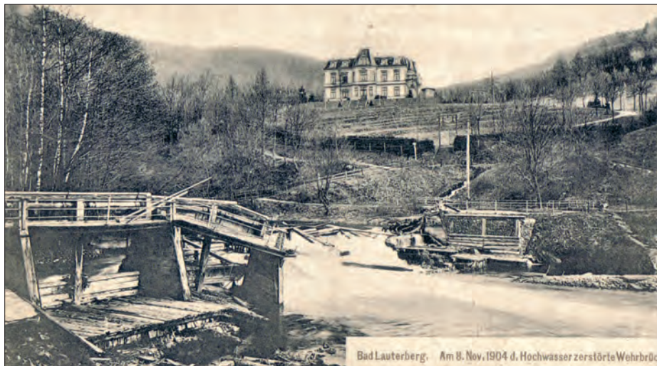
Abb. 54: Vom Hochwasser im November 1904 zerstörte Wehrbrücke an der Oder in Bad Lauterberg/Harz
